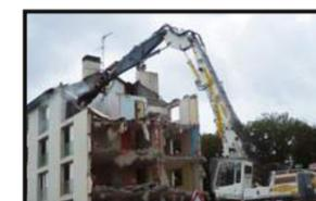
Une phase de démolition du gros-cœur par le biais d'un engin de travaux équipé d'une pince. Les matériaux démolis seront transformés en granulats qui seront ensuite recyclés pour de nouveaux chantiers. Si besoin, l'entreprise procédera à des brumisations pour éviter les nuisances aux riverains dues à la poussière.
