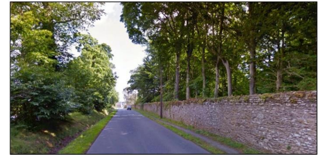
Fig. 14 : mur d'enceinte allée du Marquis
